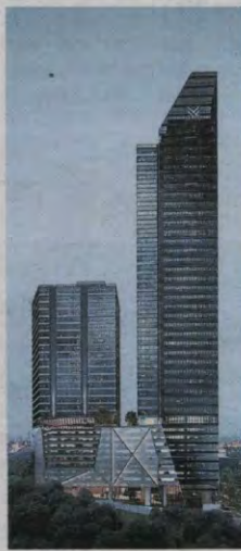
MET 企业大楼由 2 栋一高一矮的高楼组成，以玻璃幕墙带出摩登风格。
